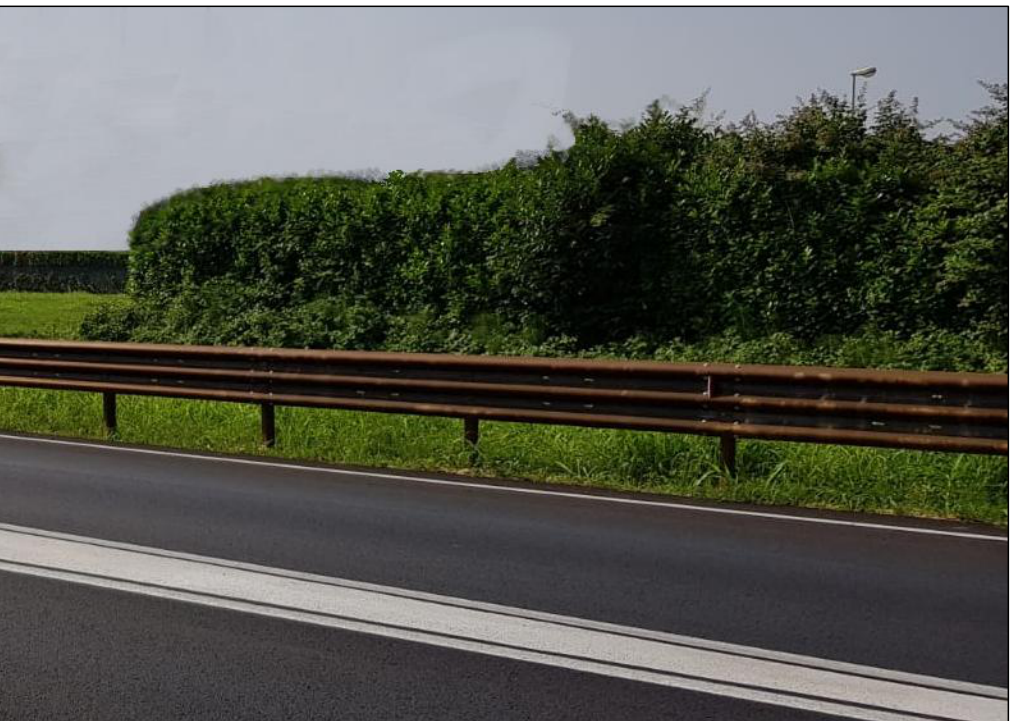
BARRIERA STRADALE DI SICUREZZA IN ACCIAIO CON FINITURA CORTEN
